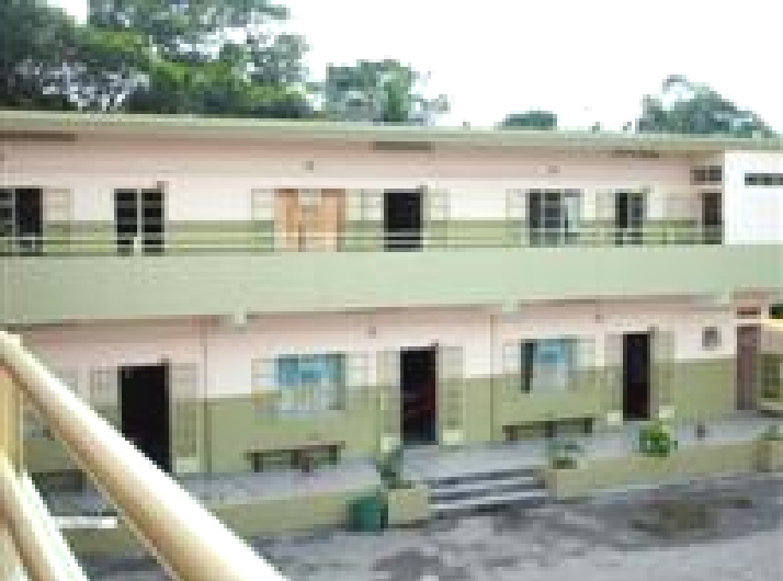
Notre Dames Des Anges Renovation
